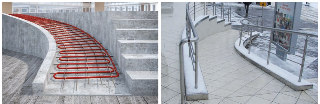
Slika 41. KAN-therm Grijanje vanjskih površina – tokom i nakon završetka radova
