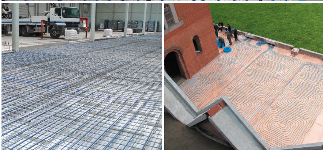
Slika 4. Instalacija podnog grijanja u industrijskom pogonu, koristeći PE-RT plave podne cijevi i KAN-therm NET sistem.
