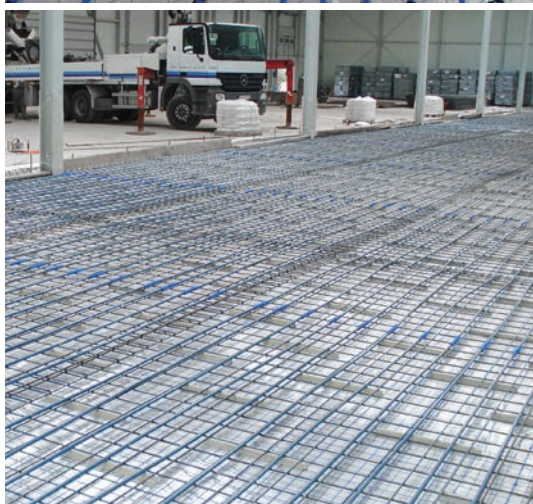
Slika 4. Instalacija podnog grijanja u industrijskom pogonu, koristeći PE-RT plave podne cijevi i KAN-therm NET sistem.
